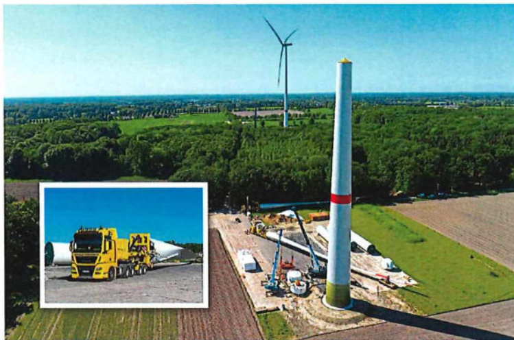
Die erste der beiden in Bösensell genehmigten Anlagen steht, die zweite ist im Bau. Auch der Transport der Rotorblätter funktionierte laut Projektentwickler reibungslos.
